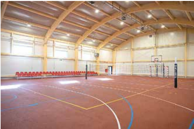
Budowa funkcjonalnego obiektu trwała ledwie kilka miesięcy.
