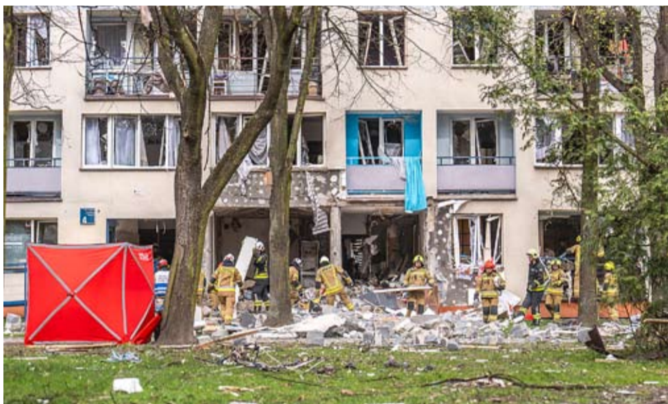
W wyniku wybuchu ucierpiały mieszkania na trzech kondygnacjach bloku przy ul. Darwinia 4.
