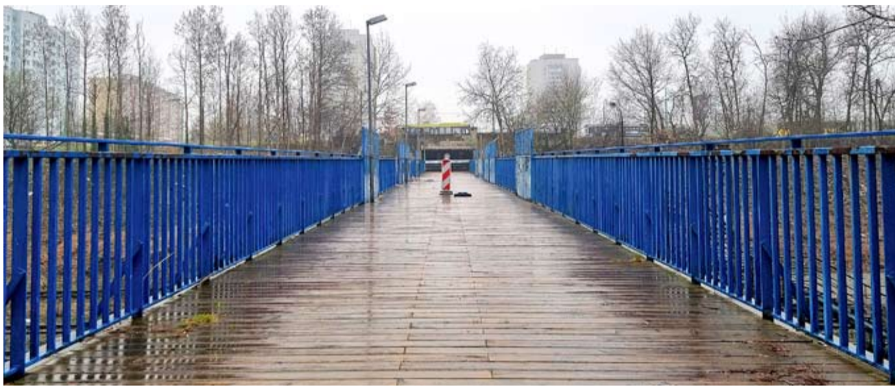
Kładka nad wykopem kolejowym będzie wyremontowana w tym roku.
