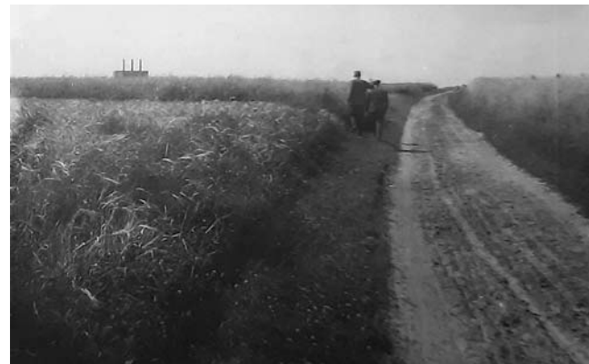
Tak wyglądał teren, na którym w polowie lat 60. ubiegłego wieku rozpoczęto budowę Przedsiębiorstwa Dostaw Materiałów Odlewniczych.
