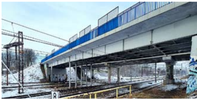
Widoczny na zdjęciu południowy wiadukt na ul. Mikołowskiej został zamknięty, a wkrótce będzie wyburzony.
