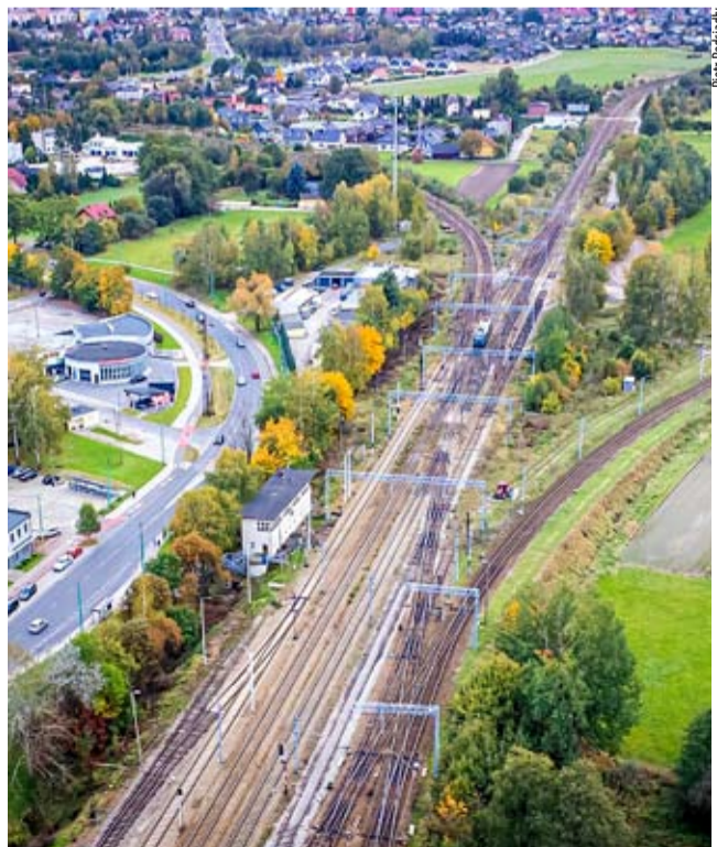
Modernizacja przebiegającej przez Tychy trasy kolejowej pochłonie prawie miliard złotych.
