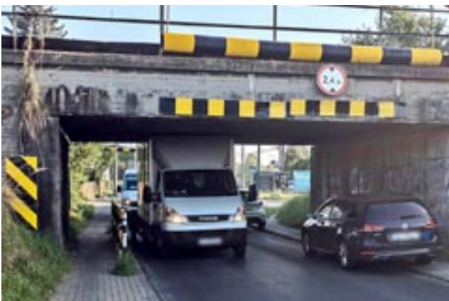
Jeden z wielu przypadków zaklinowania się auta pod wiaduktem na Glincańskiej.
