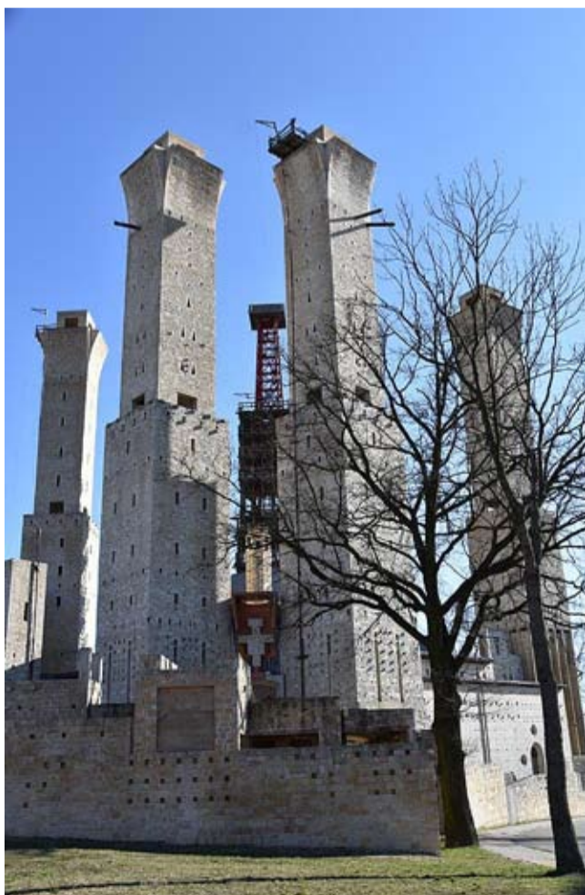
Franciszkański klasztor w budowie jest jednym z ostatnich „obowiązkowych” obiektów na trasie Tyskiej Pętli Rowerowej.
