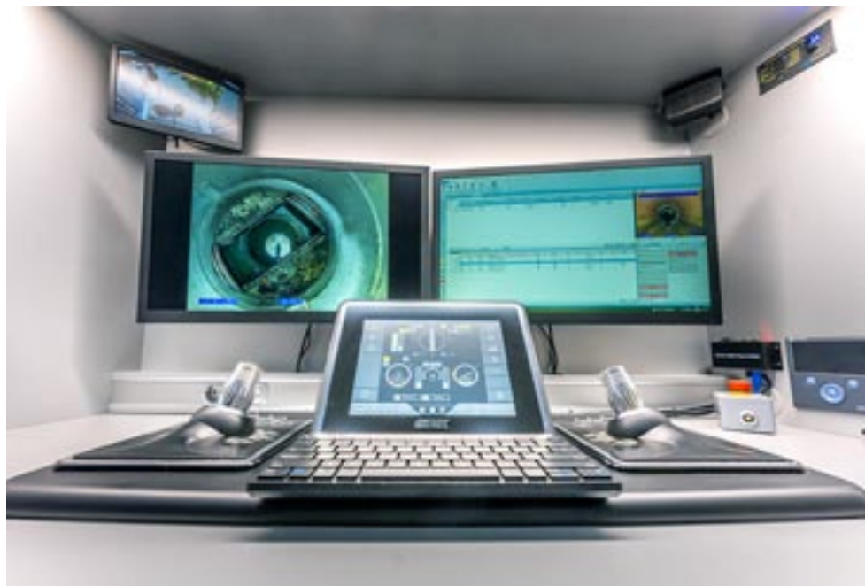
Obraz z wnętrza sieci kanalizacyjnej można oglądać na bieżąco na monitorach zainstalowanych w pojeździe.
