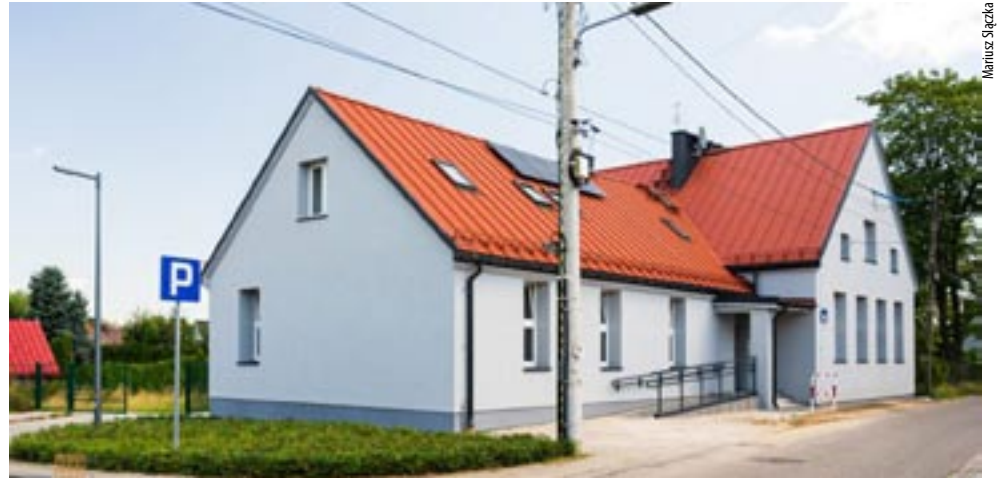
Gmina zakończyła inwestycję przy ul. Szkolnej 70.
