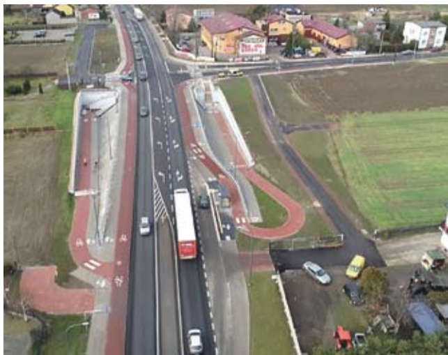
Dzięki podziemnemu przejściu, zwiększy się bezpieczeństwo pieszych i rowerzystów.
