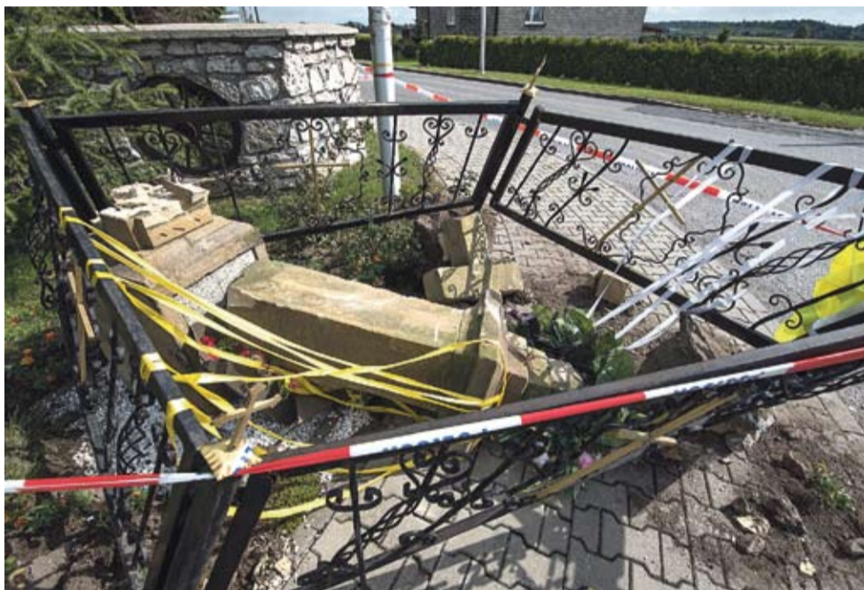
Prace renowacyjne ruszą dopiero na wiosnę.
