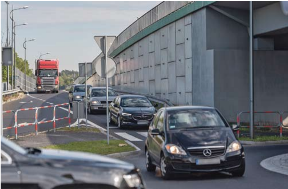
Cały ruch tranzytowy na DK1 zamiast górą wiaduktu odbywa się teraz przez rondo pod wiaduktem.
