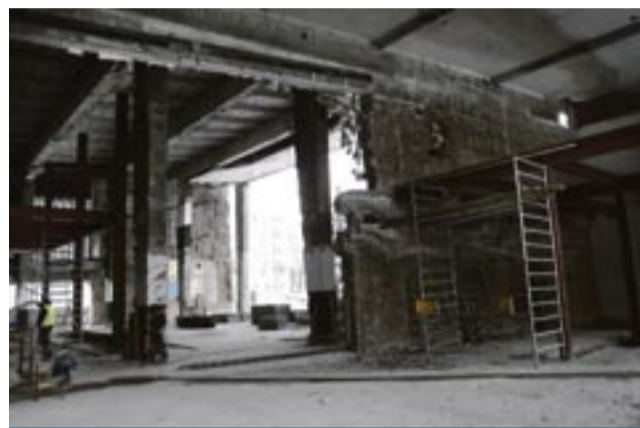
W Andromedzie zakończyła się rozbiórka elementów konstrukcji.
