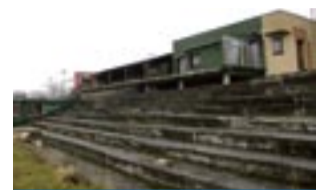
Trwa rozbiórka pawilonu sportowego i trybun.
