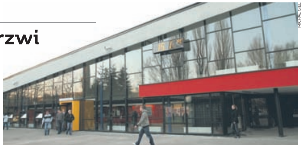
Remont dworca trwał pięć miesięcy.
